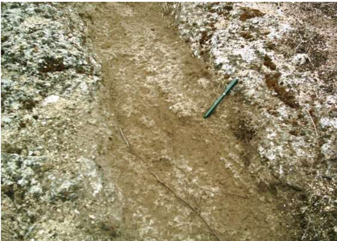
Figura 10 Detalle del canal excavado en la roca
